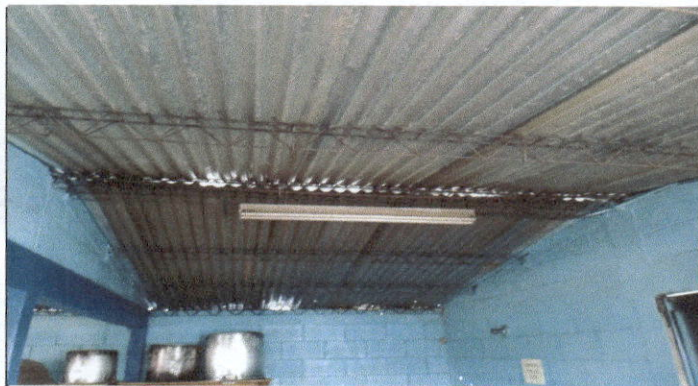
Foto 3: Sustitución de Estructura de Techo
