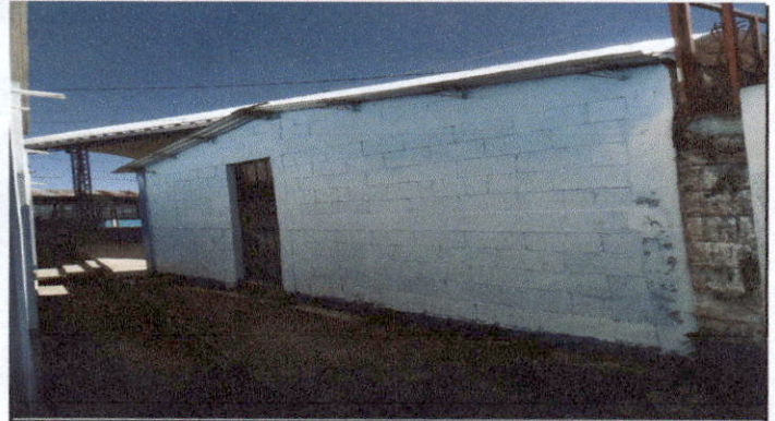
Foto 2: Sustitución de Puertas
