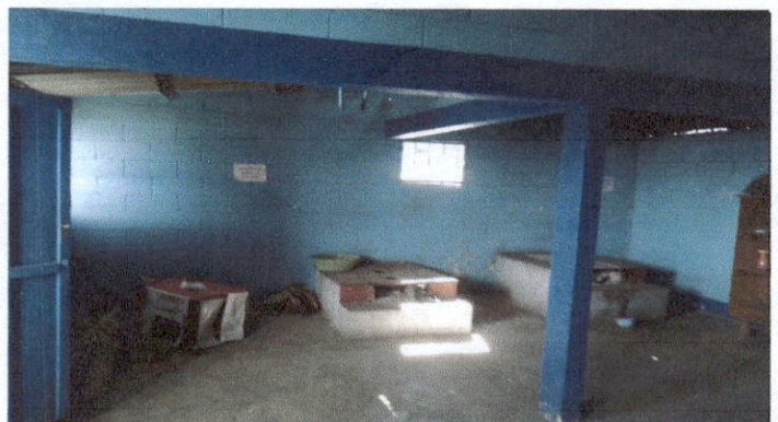
Foto 4: Sustitución de Piso de Cemento
